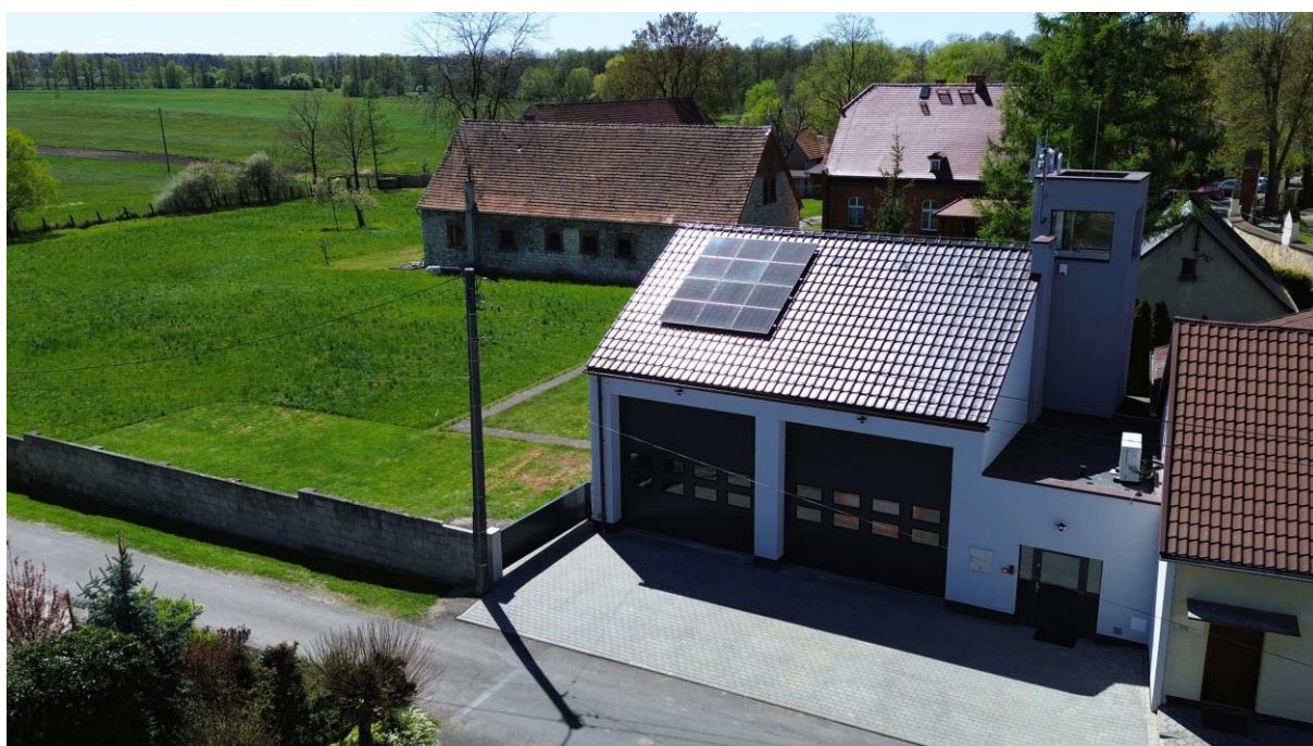
Rozbudowana remiza OSP w Dębieniu (źródło: Urząd Gminy Chrzastowice)
