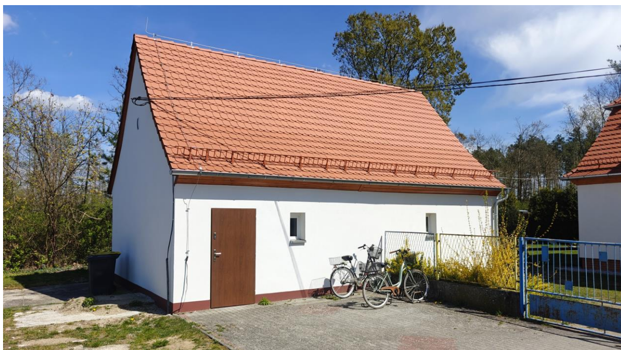
Prace remontowe budynku gospodarczego przy świetlicy wiejskiej na potrzeby magazynowe sołectwa w Suchym Borze (źródło: Urząd Gminy Chrzastowice)
