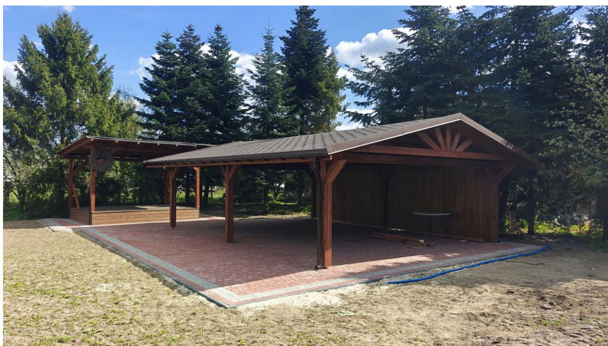
Budowa altany ogrodowej na placu rekreacyjnym przy świetlicy wiejskiej w Lędzinach (źródło: Urząd Gminy Chrzastowice)
