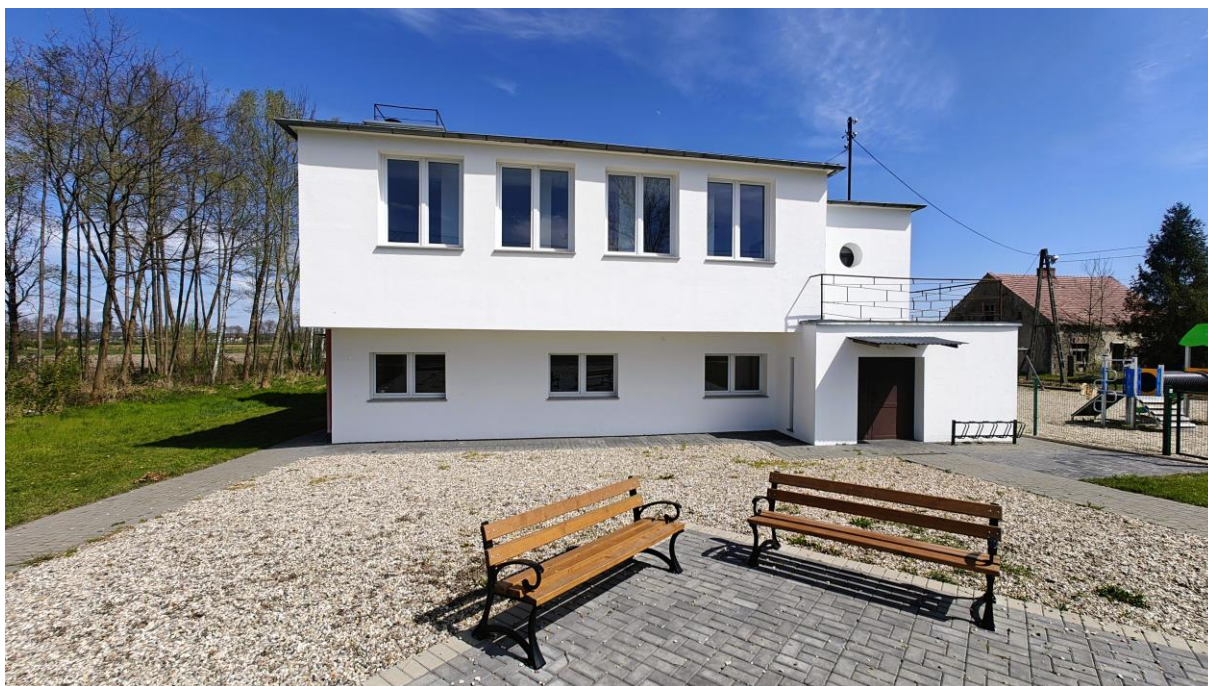
Malowanie elewacji i prace remontowe w świetlicy wiejskiej w Dąbrowicach (źródło: Urząd Gminy Chrzastowice)
