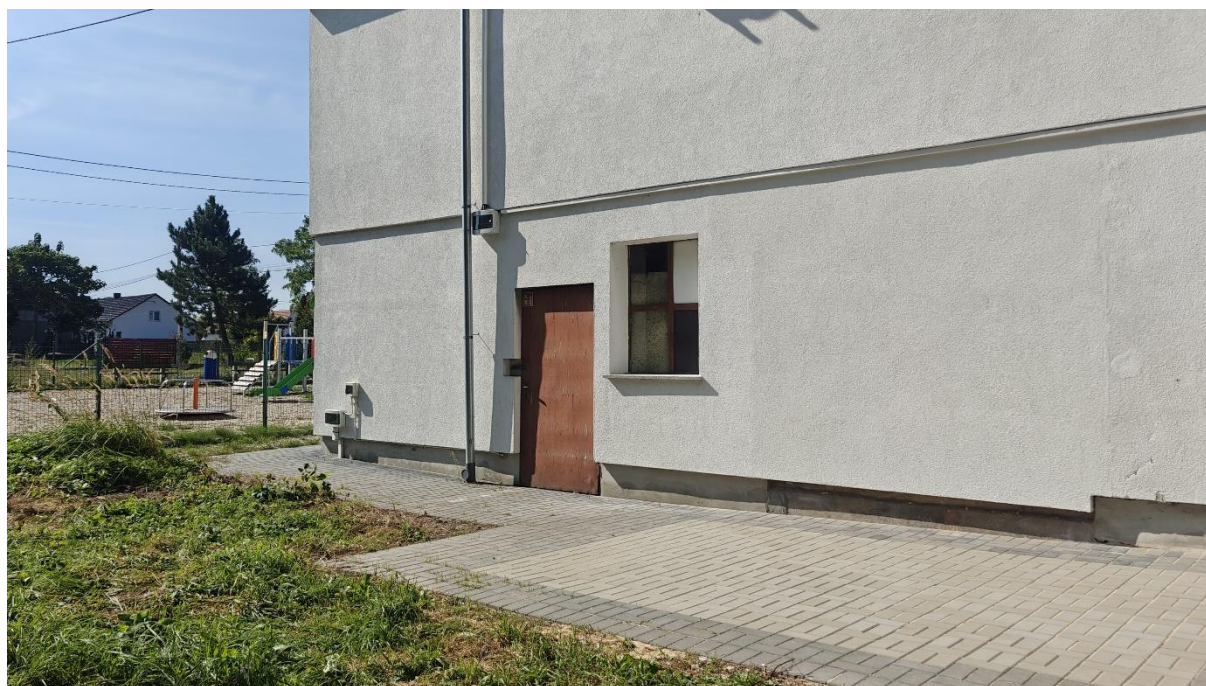
Rozbiórka przybudówki oraz zagospodarowanie terenu przy świetlicy wiejskiej w Dąbrowicach (źródło: Urząd Gminy Chrzastowice)
