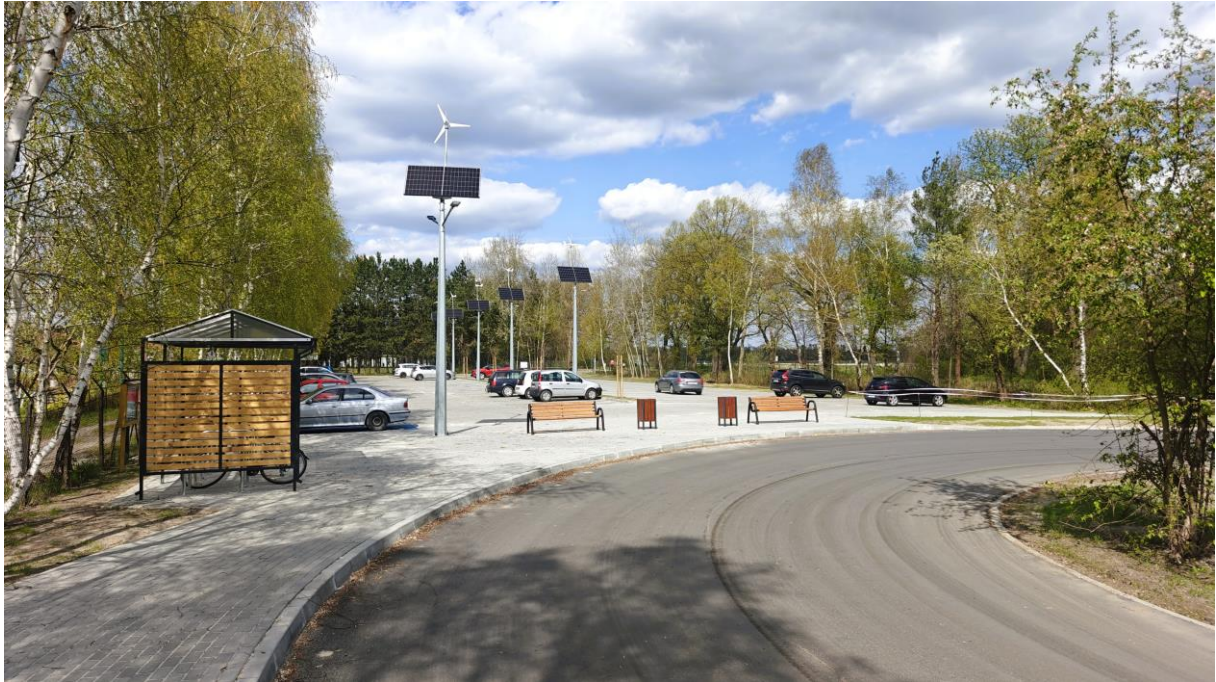
Budowa centrum przesiadkowego wraz z przebudową pętli autobusowej i parkingu w m. Lędziny (źródło: Urząd Gminy Chrzastowice)
