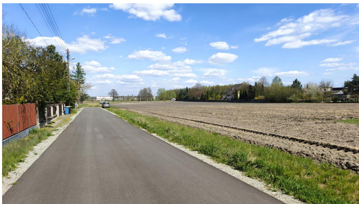
ul. Nowa w Suchym Borze (źródło: Urząd Gminy Chrzęstowice)
