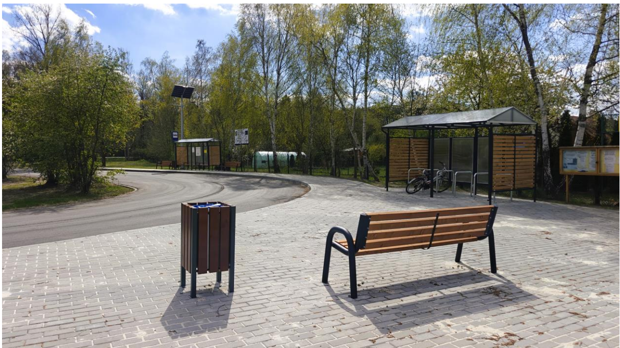
Budowa centrum przesiadkowego wraz z przebudową pętli autobusowej i parkingu w m. Lędziny (źródło: Urząd Gminy Chrzastowice)
