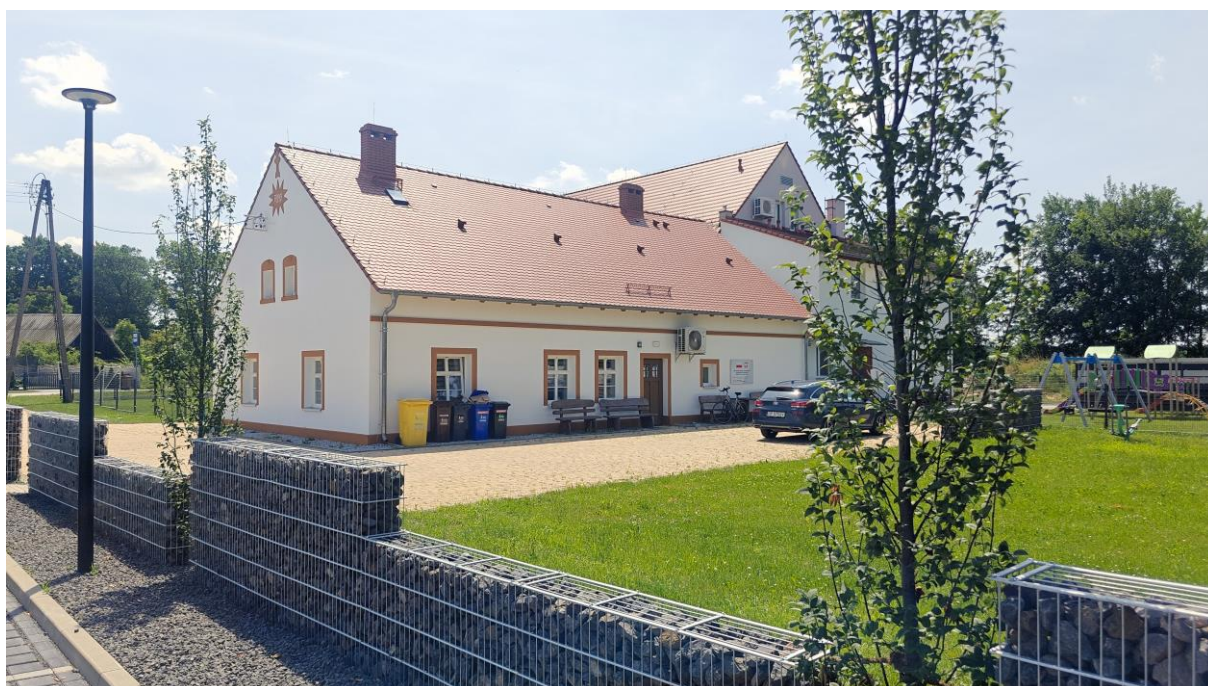
Ogrodzenie z koszy gabionowych przy Domu Dziennego Pobytu w Chrzastowicach (źródło: Urząd Gminy Chrzastowice)
