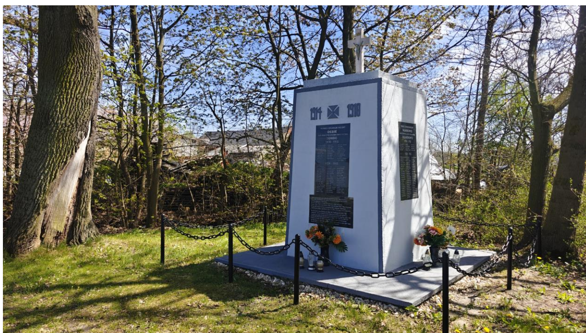
Prace renowacyjne oraz czyszczenie pomnika poległych w I Wojnie Światowej w Dębju (źródło: Urząd Gminy Chrzastowice)
