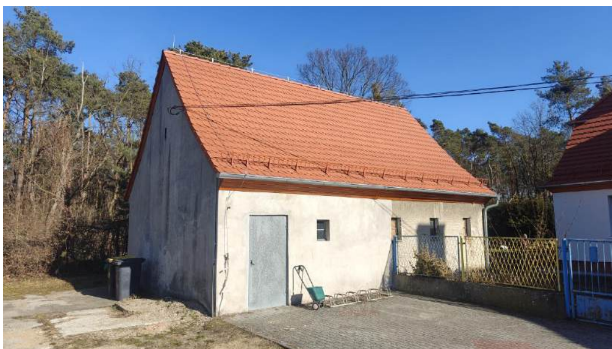
Remont budynku gospodarczego przy świetlicy wiejskiej w Suchym Borze
