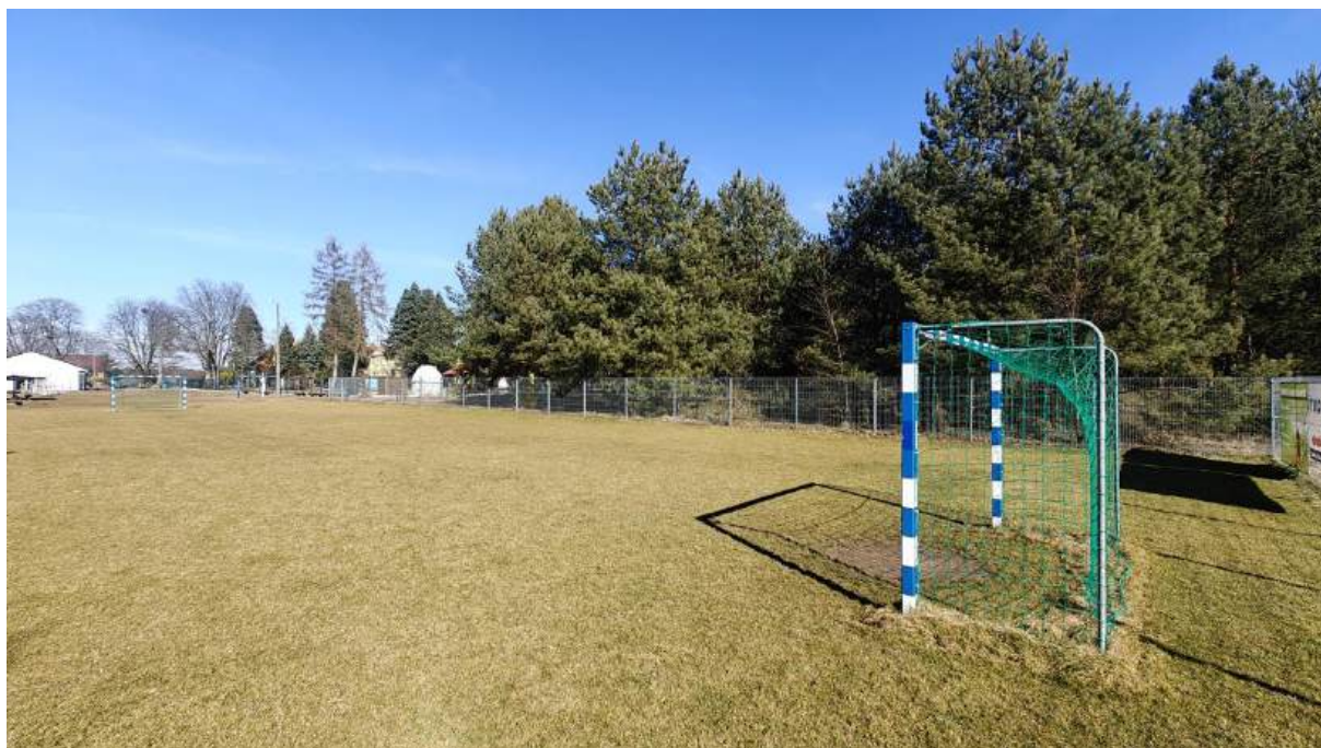
Zagospodarowanie placu rekreacyjno-sportowego przy świetlicy wiejskiej (budowa boiska) w Niwkach
