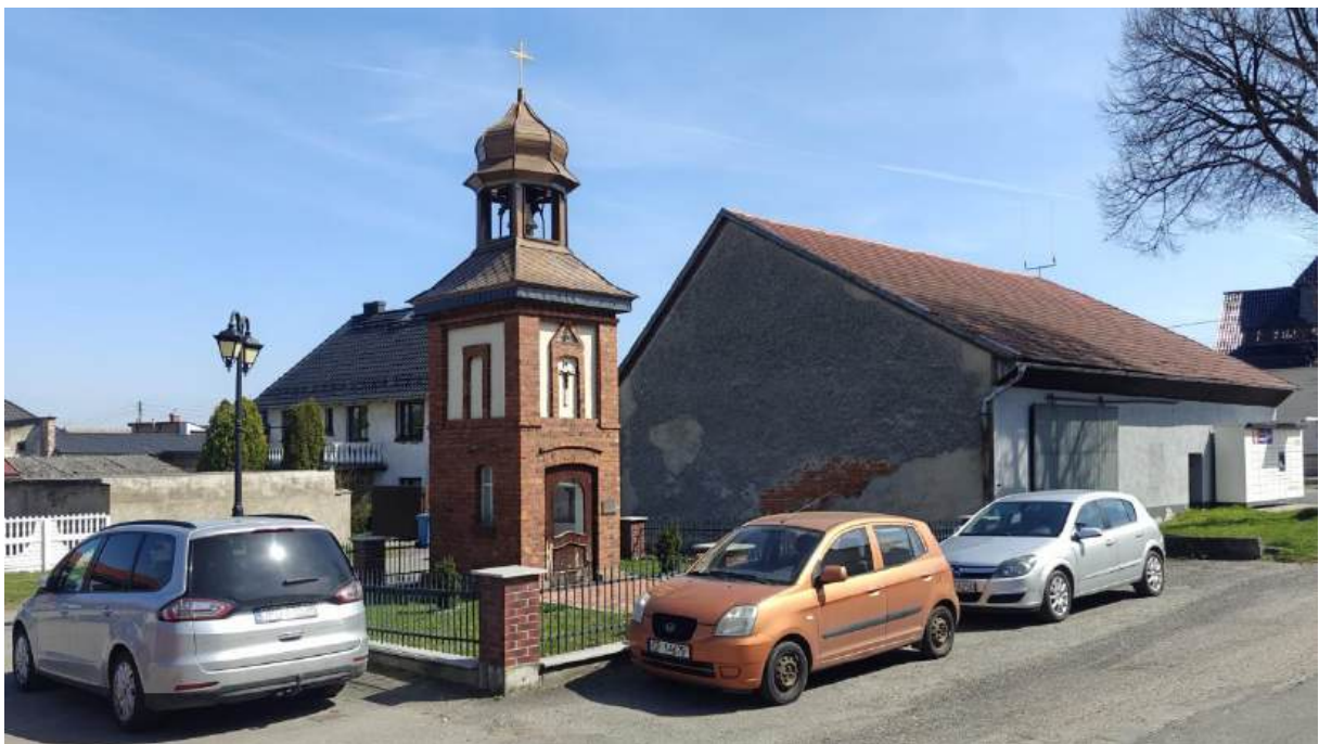
Kaplica dzwonnica w Dańcu
