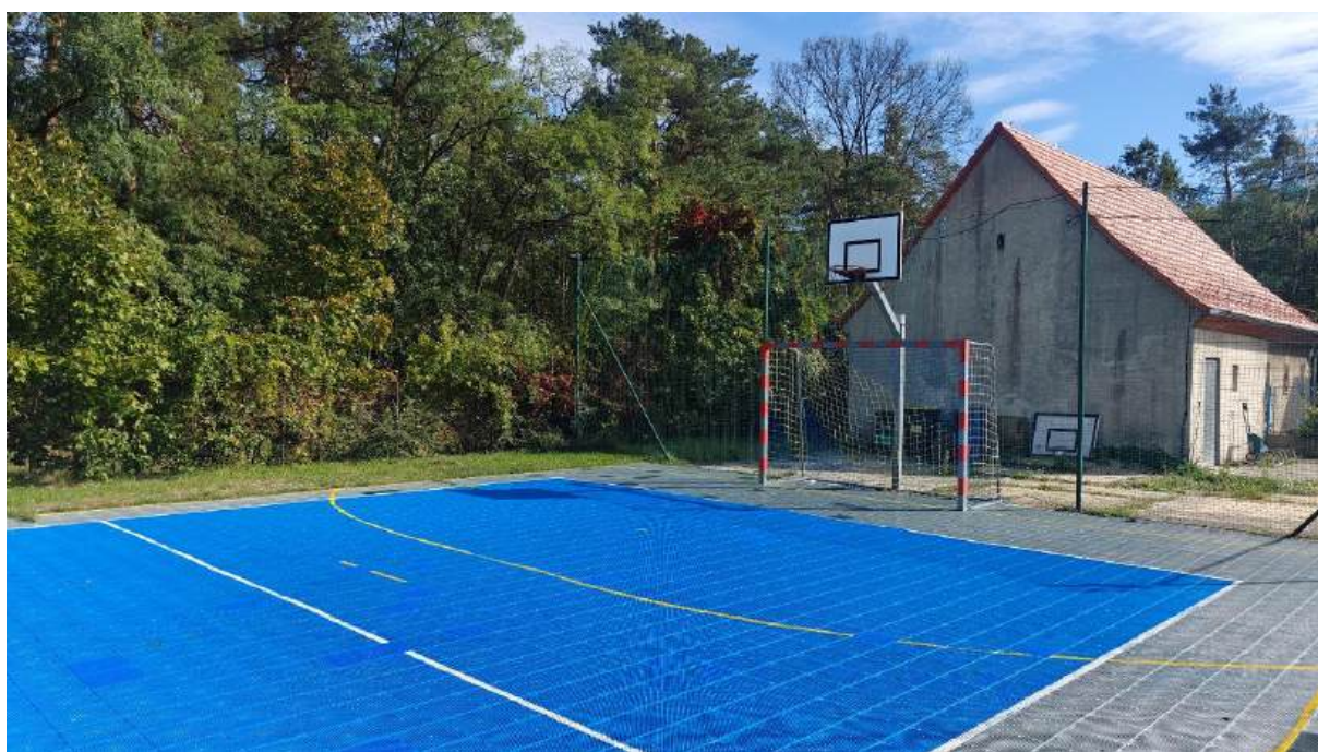
Renowacja boiska wielofunkcyjnego w Suchym Borze
