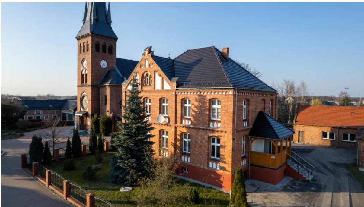
Plebania kościoła Parafialnego pw. Niepokalanego Poczęcia NMP w Chrzastowicach
