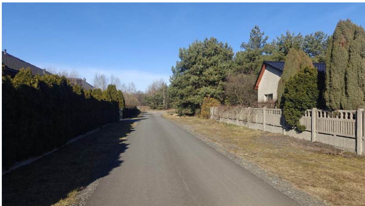
Wykonany asfalt na ul. 1 Maja w Chrzęstowicach
