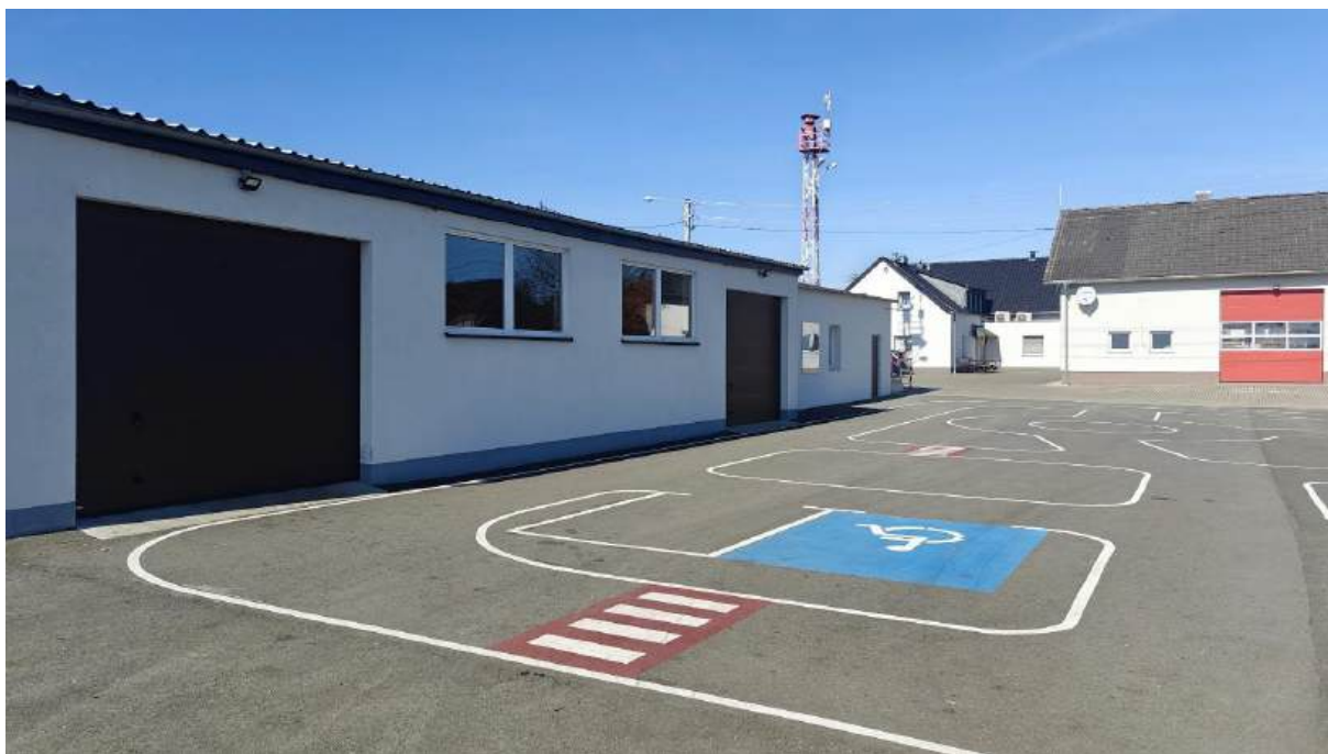
Ocieplenie budynku gospodarczego na terenie placu samorządowego przy ul. Kolonia 12 w Dębskiej Kuźni
