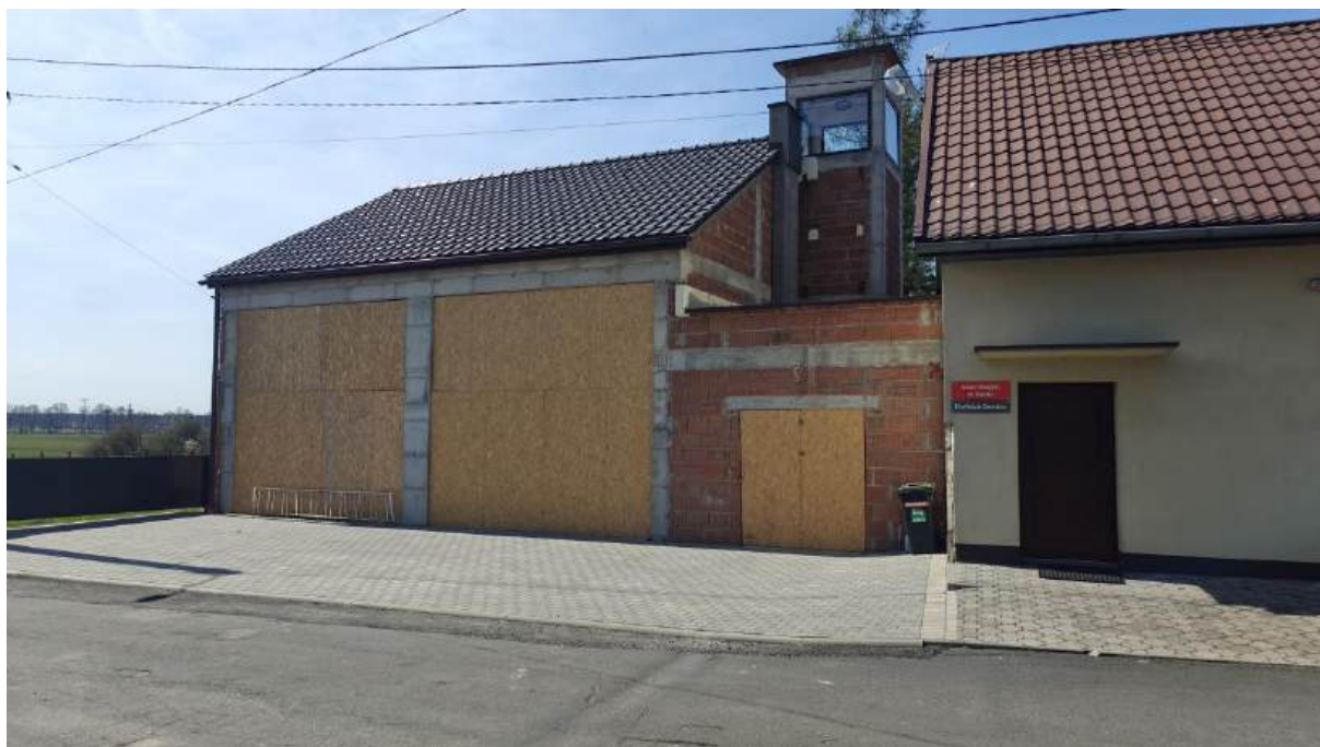
Rozbudowa remizy OSP w Dębina (etap II)
