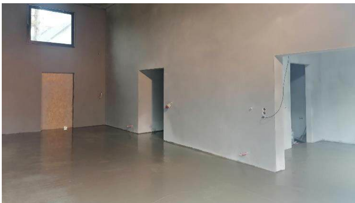
Rozbudowa remizy OSP w Dębina (etap II)
