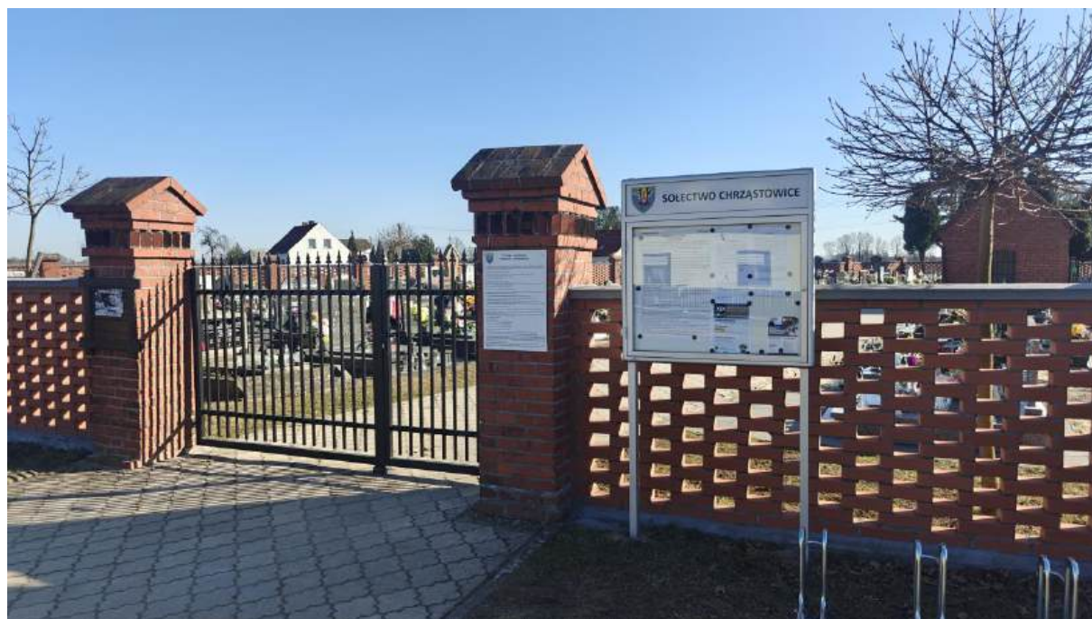
Wykonanie i montaż bramy cmentarnej w Chrzastowicach
